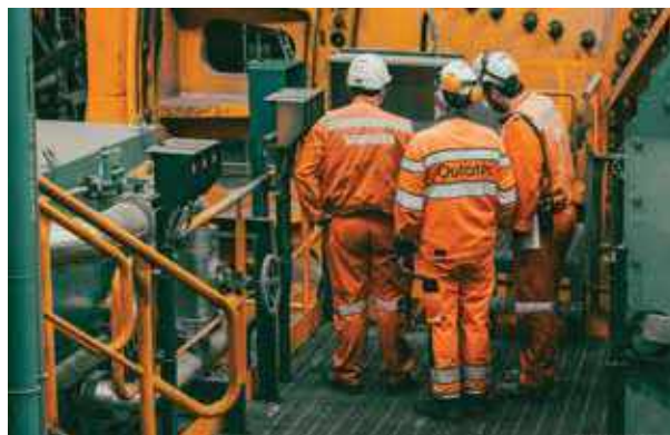
Mill Plant, Neves-Corvo, Portugal
